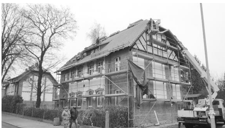
Dzięki finansowemu wsparciu władz miasta Ruda Śląska, w ciągu minionych kilku lat przy ulicy Ks. Niedzieli 22, 24, 26, 30, 32 powstała enklawa kilku gruntownie zrewitalizowanych zabytkowych budynków mieszkalnych znajdujących się w zasobach GSM „Luiza”.
