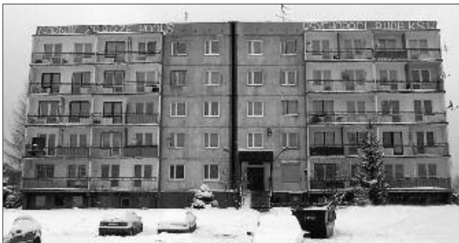
W budynku przy ul. Piwnikarczyka 6 w Rudzie Śl. trwa remont instalacji zimniej i ciepłej wody.
