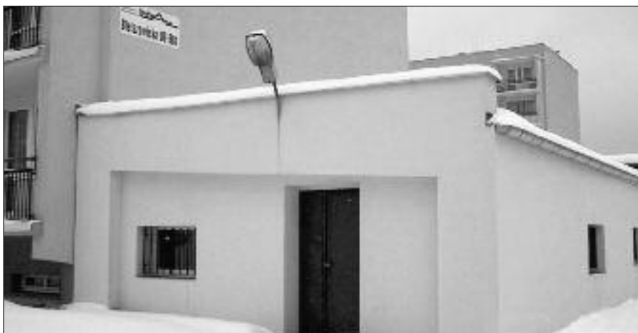
W zaadoptowanych pomieszczeniach po starej kotłowni przy ul. Bielszowickiej 98 w Rudzie Śl. będzie nowa siedziba administracji osiedla.
