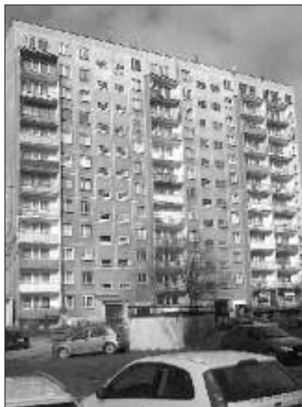
Najwyższymi budynkami GSM „Luiza” są budynki 11. kondygnacyjne wys. ok. 33 m położone przy ul. Banachiewicza 17 w Zabrze (na zdjęciu) oraz w Rudzie Śląskiej przy ul. Paderewskiego 17/17a - Kąty Jankowskie.
