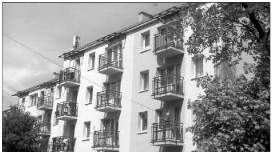
Montaż daszków nad balkonami ostatniej kondygnacji budynku przy ul. Ks. Niedzieli 51 w Rudzie Śląskiej.
