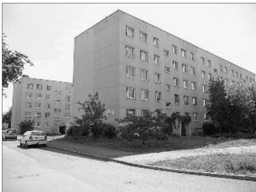
W budynkach GSM „Luiza” przy ul. Pordzika trwają prace przy wymianie instalacji gazowej.
