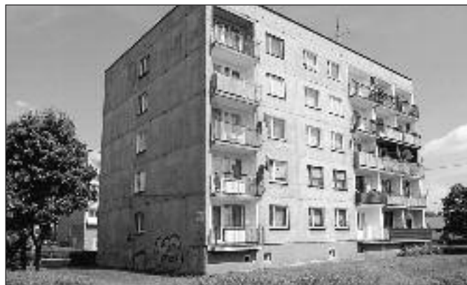
Ul. Korczoka 85 – pierwszy budynek, który będzie wykonany według nowych zasad realizacji i finansowania inwestycji termomodernizacyjnych.
