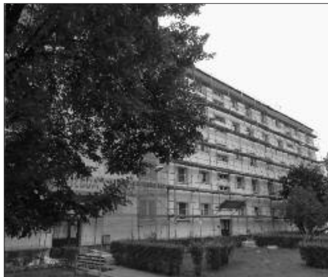
Dobiega końca termomodernizacja budynku przy ul. Międzyblokowej 3-3d w Rudzie Śl.
