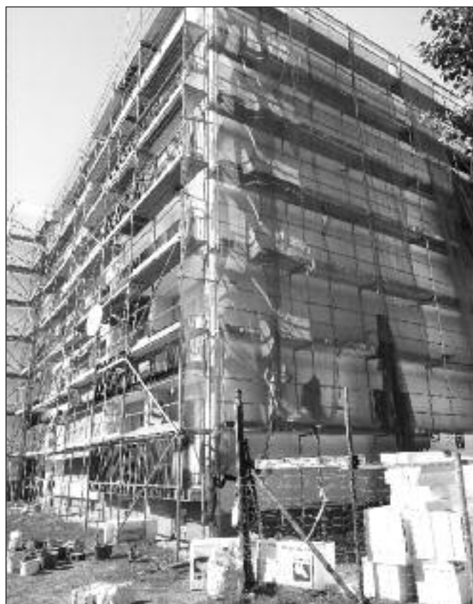
Termomodernizacja budynku GSM „Luiza” w Zabrzcu, przy ul. Kalinowej 11-11e.
