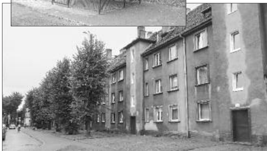
W nieruchomości przy ul. Kobylińskiego 2 - 10 w Zabrze wraz z malowaniem klatek schodowych zamontowano z uwzględnieniem funkcjonalności, nową stolarkę okienną.
